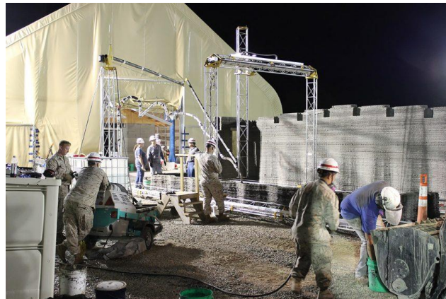
Figura 5 – Construção de camarata Fonte: Aouf (2018).
